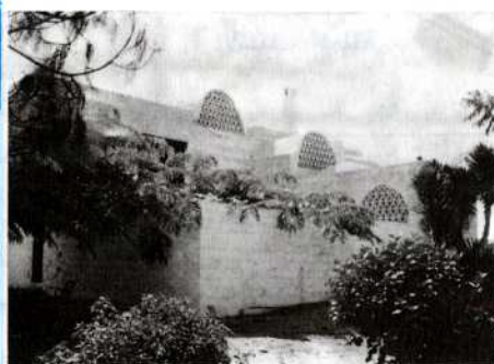
— مسكن خاص بأبو صير - الهرم من أعمال المعماري الراحل حسن فتحي ( مشروع العدد ص ١٨ )
