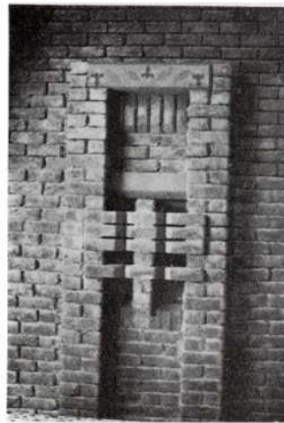
وحدات الإضاءة الداخلية المبنية في الحوائط - محاولة لإضاءة الطابع المحلي في الفراغات الداخلية للفندق .
