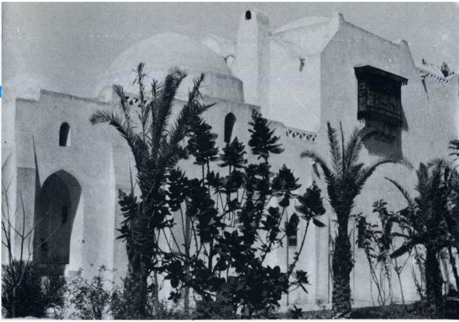
الواجهة الرئيسية للمسكن وتمتع بالطابع الريفي المصرى الاسلامى .
