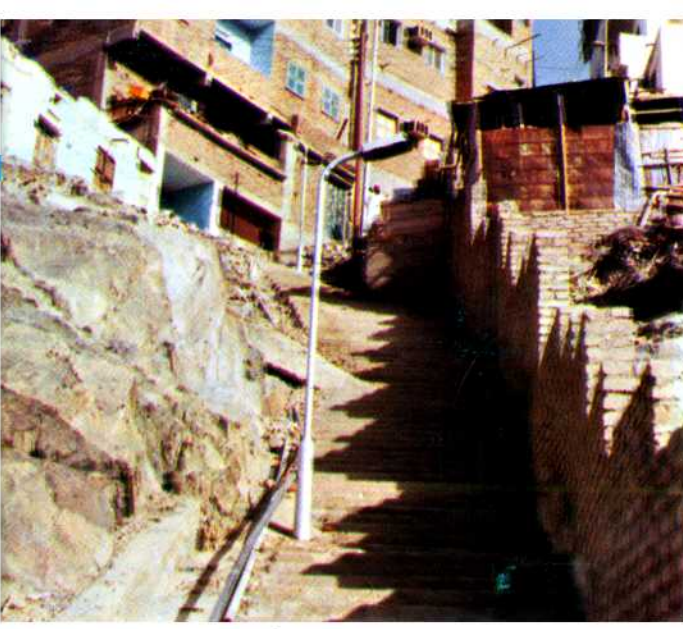
مواشير المياه فوق سطح الأرض
