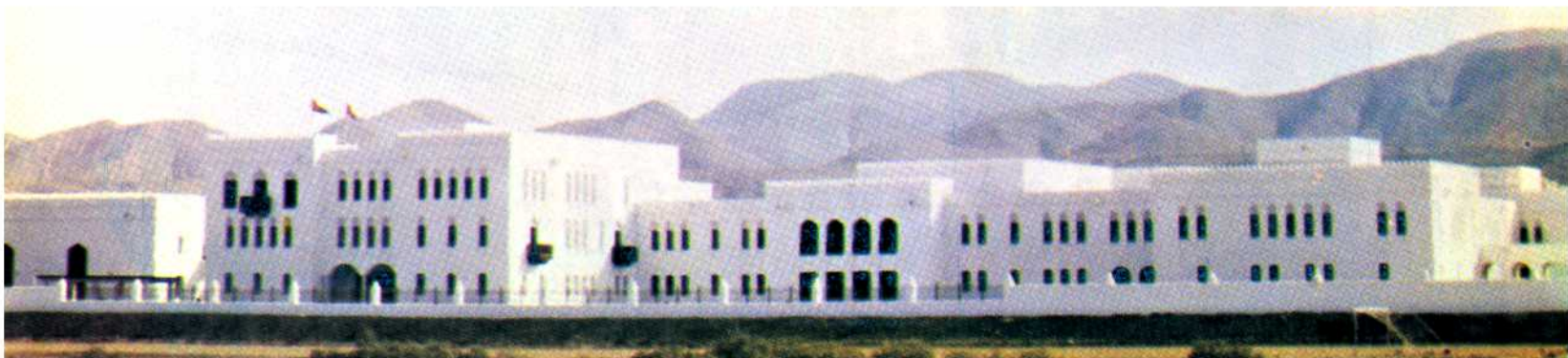
الواجهة الخلفية للمبنى
