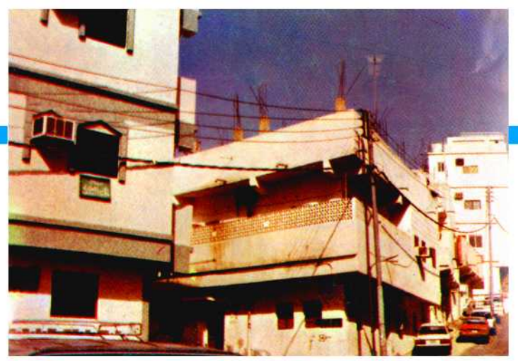
● خطورة شبكة الكهرباء الهوائية
