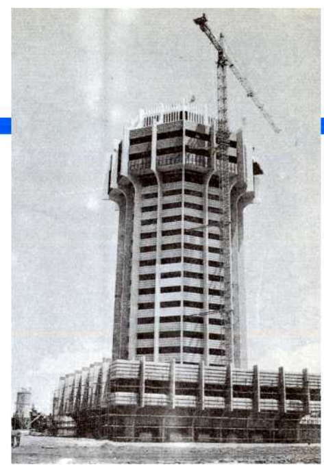
• المبنى الإداري الجديد لميناء جدة .
