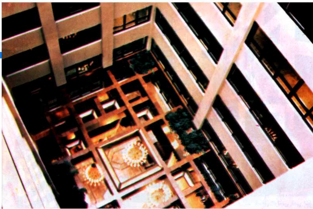
❖ شبكة الكمرات المقاطعة يهو المدخل وتستخدم كوحداث إضاءة وكأحواض زهور معلقة .
