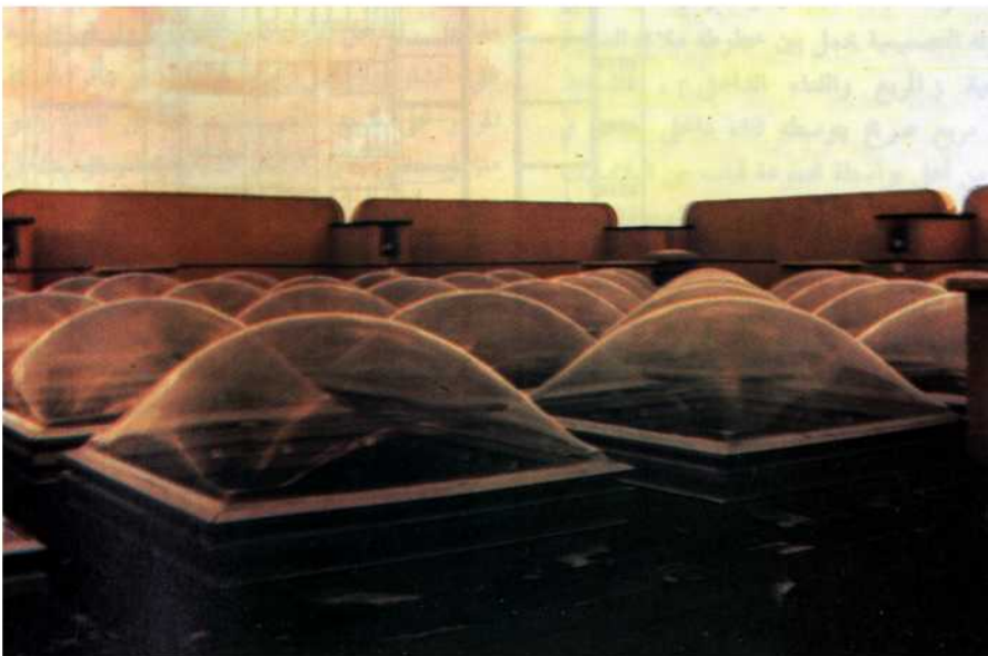
❖ تنفيذ القباب البلاستيك المستخدمة في تغطية الفناء الداخلي بالمبنى .
