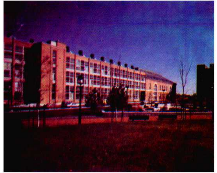
♦ واجهة المبنى الزجاجية والتي تُعد خلفية للمنتزه القومي للمدينة .
