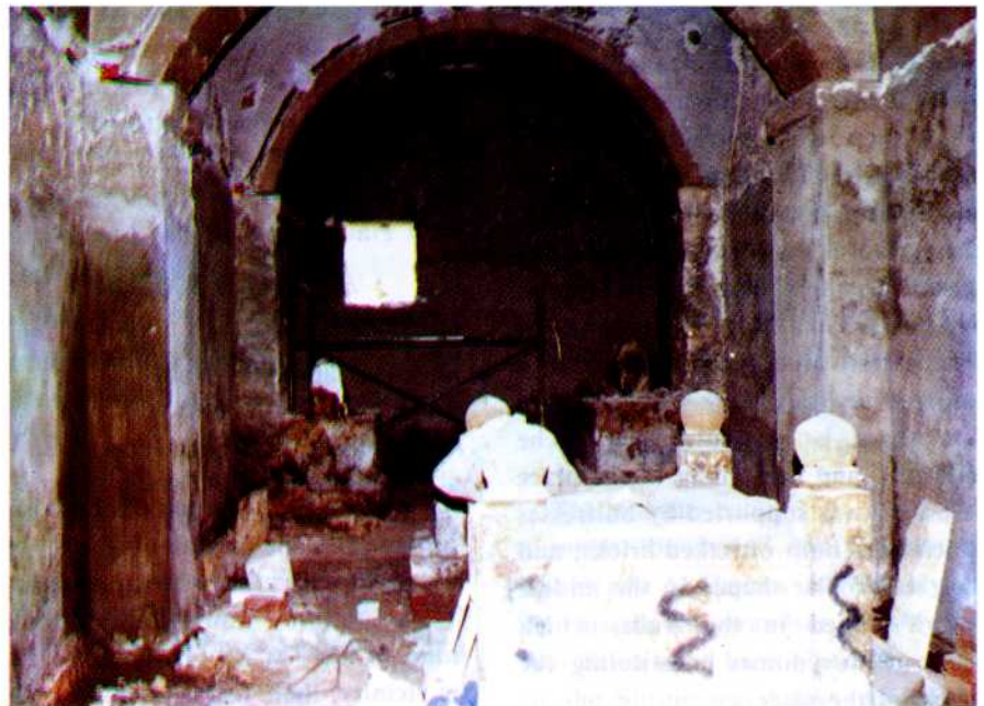
↑ منظر عام للمقابر أثناء الترميم .
