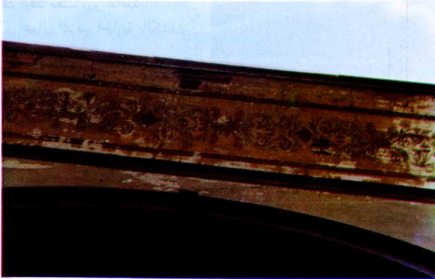
الكورنيش قبل الترميم
