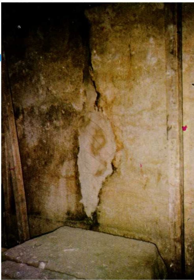
١٢ - أعمال الترميم التي أُجريت في الجدران .
