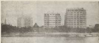
کوارتال مسکونی در بندر کابل
