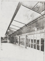
استعمال انواع السيكوريت في مظلات الضفكات والباني العامة لوقاية من الأمطار مع عدم حجب الضوء
