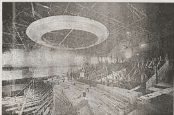
مبنى محطة توربينات الكهروكهربائية
