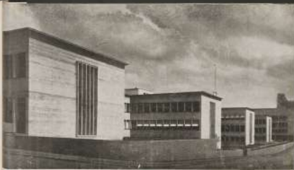
توسعة الكلية الجامعية الجديدة في الكويت عام 1965م - من المصممين: المهندس المعماري الكويتي
