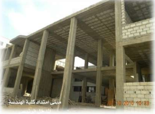
مبنى امتداد كلية الهندسة المدخل الرئيسي
