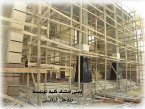
مبنى امتداد كلية الهندسة المدخل الرئيسي
