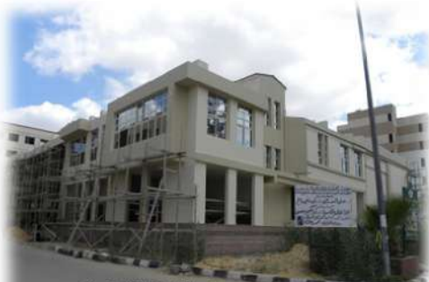
مبنى امتداد كلية الهندسة قاعة العمل الافتراضية - قاعات محاضرات مبنى إداري
