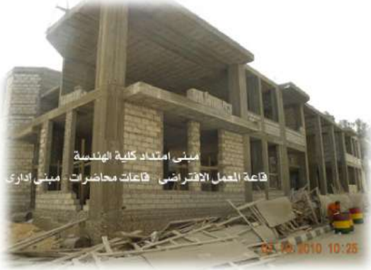
مبنى امتداد كلية الهندسة قاعة العمل الافتراضية - قاعات محاضرات - مبنى إداري
