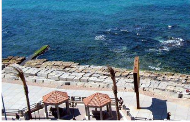
شكل (٦-٦): وضع البلوكات الخرسانية في البحر أمام حوائط الكورنيش . - المصدر: الباحثة.
