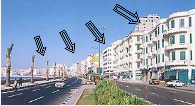
شكل (٥-٤): طلاء واجهات المباني المواجهة للبحر باللون الأبيض.
