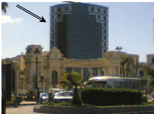
شكل (٣-٩٠): بلوك مكاتب القطن. المصدر: الباحثة.
