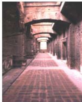
ممر داخلي بالسوق تظهر على جانبه
