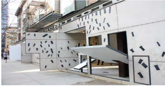
شكل (٢-٥٣) يوضح السطح القابل للتشغيل ( Operable Surface ) - المصدر - https://aroundchinatown.wordpress.com/2012/03/08/tenement-museum-storefront-moca
