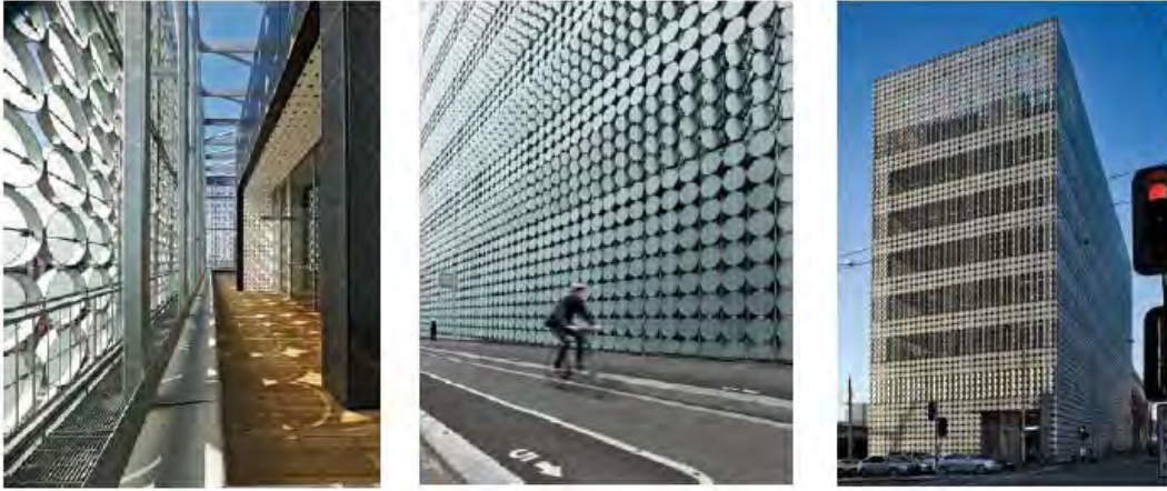
شكل (٢-٥) الحركة الديناميكية لواجهة مبنى -Design HUB (المعهد الملكى للتكنولوجيا بميلبورن ( RMIT ) إستجابة لحركة الشمس - المصدر :
