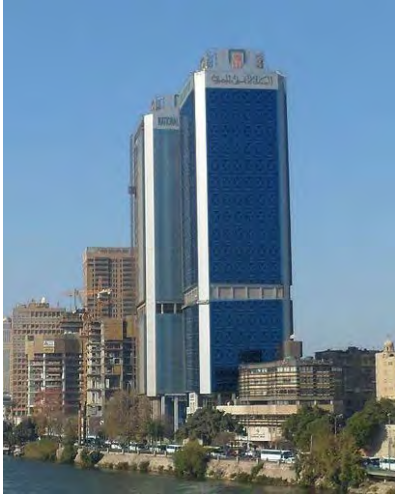
شكل (٤-٢٥) يوضح الشكل النهائى للمقترح التصميمي للبرج الجنوبي لمبنى البنك الاهلى المصرى-المصدر الباحث
