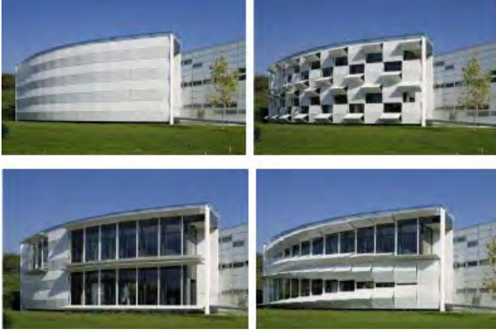
شكل (٢-٢) واجهة مبنى Kiefer technic showroom - والوضعيات المختلفة للواجهة أثناء الحركة -- أستراليا - المصدر:
