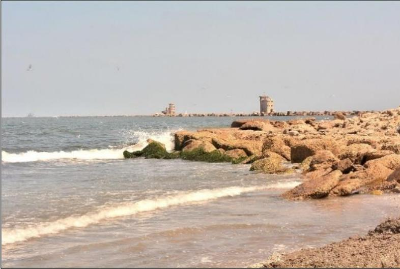
شكل رقم (7-52) صورة حاجز عند مدخل القناة لحماية منطقة الشاطئ الواقعة غرب الحاجز من التآكل
