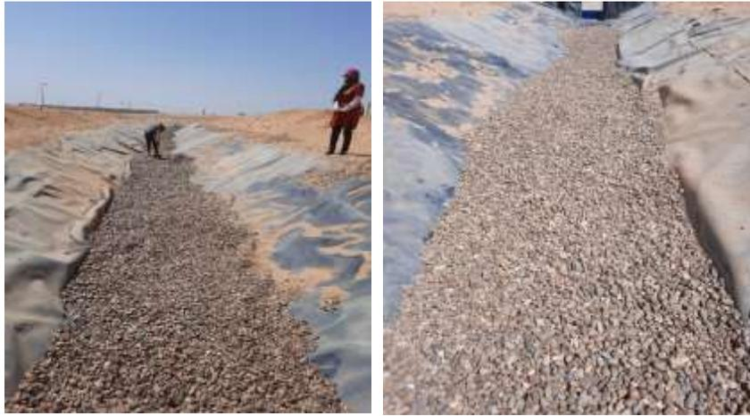
شكل ١١٤: استخدام الزلط لتنقية المياه<sup>٣٠٧</sup>
