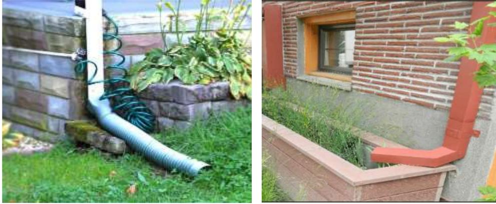
شكل ٢٨: صورة لتصريف مياه الأمطار من الأسطح<sup>٨٣</sup>
