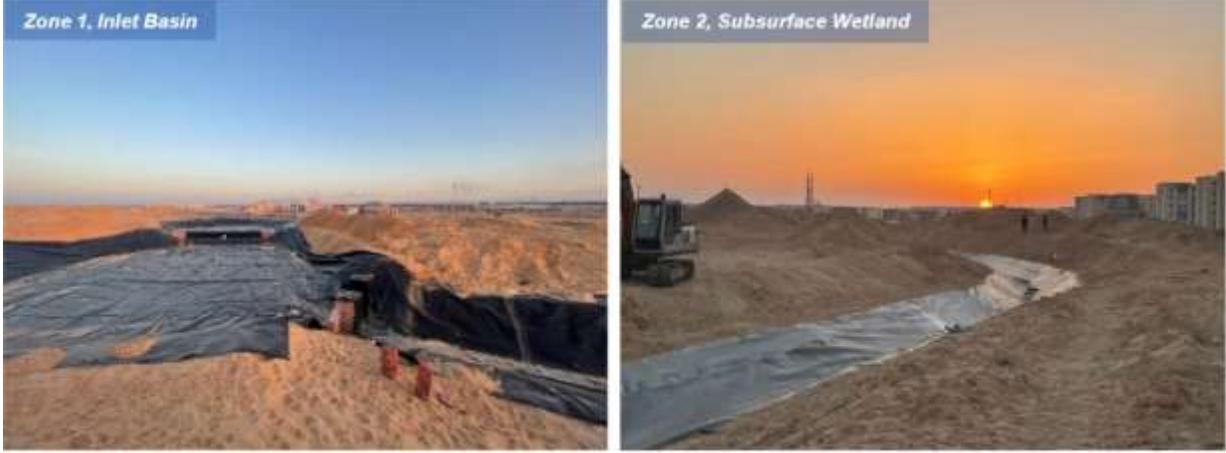
شكل ١١١: عزل الممر المائي في الحديقة<sup>٣٠٤</sup>
