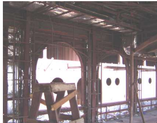
شكل (٢-٧٤): دكت تكيف جانبي في سقف مطعم عائم قيد الإنشاء
