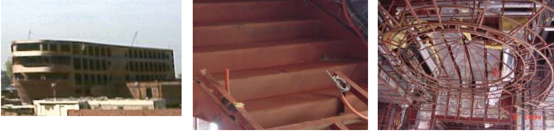
شكل (٣-٣٦): الحديد هو عنصر الإنشاء الأول في الفنادق العائمة.
