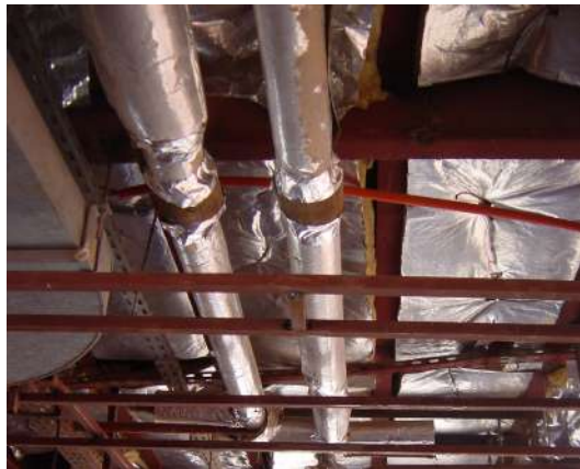
شكل (٢-٧٥): مواسير المياه المثلجة المعزولة في السقف إلى وحدات المناولة
