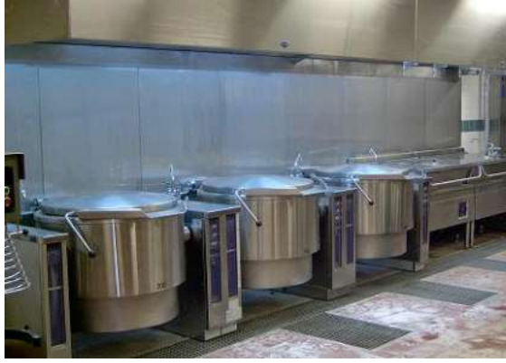
شكل (٣-٤٧): منطقة تجهيز تظهر فيها تجاليد استانلس
