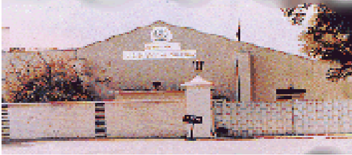
شكل (١٥): إعادة تأهيل مبنى مجلس النواب المؤقت في لاکورتی کمبني تابع للكلية الحربية للدفاع الوطني والقوات المسلحة
