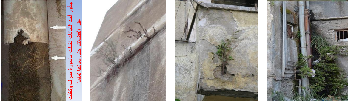
شكل (٥): تأثير مشاكل الأعمال الصحية على نهو الواجهات الخارجية للمباني، (الدراسة الميدانية، الباحث) هل هذا هو مفهوم العمارة الخضراء لدى المماريين والإنشائيين في مصر؟؟؟
