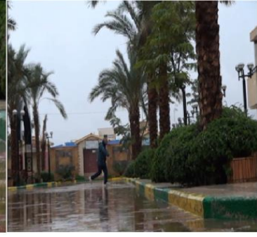
شكل (١٨): عدم وجود شبكات وميول لصرف مياه الأمطار لأعمال تنسيق الموقع (الدراسة الميدانية، الباحث)
