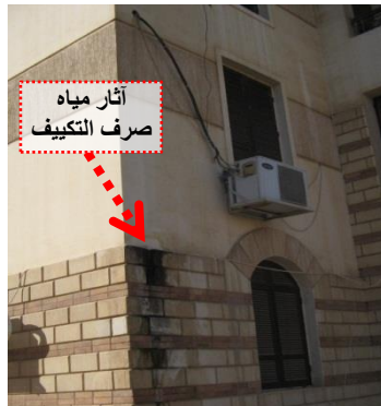
شكل (١٩): صورة تظهر تشابك وتداخل مسارات الصرف في المباني بشكل عشوائي (الدراسة الميدانية، الباحث)
