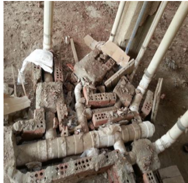
شكل (١٩): صورة تظهر تشابك وتداخل مسارات الصرف في المباني بشكل عشوائي (الدراسة الميدانية، الباحث)
