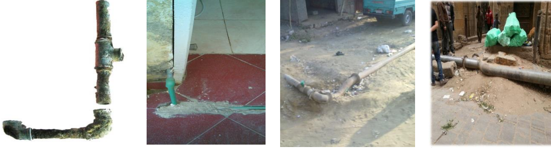
مواسير حديد مجلفن غير معزولة توصيلات عشوائية مواسير مكشوفة فوق الأرض معرضة للتلف والتسرب شكل (١١): التنفيذ السيء لمواسير التغذية (الدراسة الميدانية، الباحث)
