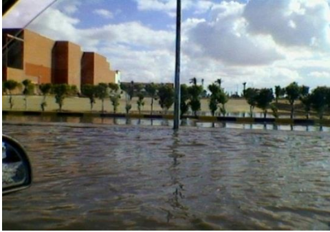
شكل (١٨): عدم وجود شبكات وميول لصرف مياه الأمطار لأعمال تنسيق الموقع (الدراسة الميدانية، الباحث)
