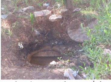
ترك أحد غرف التفريغ مفتوحة يحيط بها الطمي يعرضها للسدد
