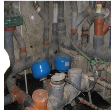
شكل (١٩): صورة تظهر تشابك وتداخل مسارات الصرف في المباني بشكل عشوائي (الدراسة الميدانية، الباحث)
