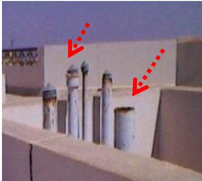
شكل (٢٠): عدم وضع أغطية علوية لمواسير الصرف يعرضها للسدد والتلف (الدراسة الميدانية، الباحث)
