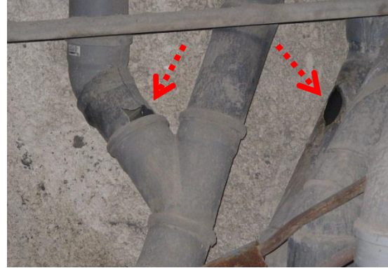
تآكل بعض الأجزاء بواسطة القوارض
