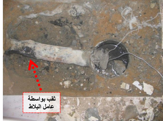
شكل (٢٢): ثقب في ماسورة صرف من الرصاص بواسطة عامل البلاط (الدراسة الميدانية، الباحث)
