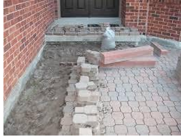
شكل (١٨): سهولة فك وتركيب الانترلوك لأعمال صيانة ومد الشبكات، الباحث
