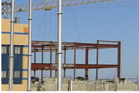
شكل (١٤): استخدام القطاعات المعدنية في إنشاء توسع رأسى لمبنى مستشفى جامعة ٦ أكتوبر، الباحث.
