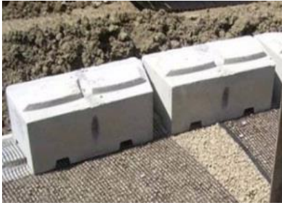
شكل (١٥): نماذج مختلفة لاستخدام بلوكات الطوب المتداخلة والمفرغة في الحوائط الحاملة، شبكة الإنترنت.
