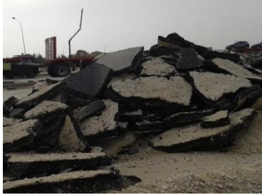
شكل (١٩): مخلفات أسفلتية أثناء رفع كفاءة أحد الطرق "وصلة دهشور" ٦ أكتوبر، الباحث
