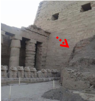
شكل (٨): استخدام قوالب من الطوب اللبن وكسر الفخار كمنحدرات لبناء الصرح الأمامي بمعبد الكرنك، الأقصر، الباحث
