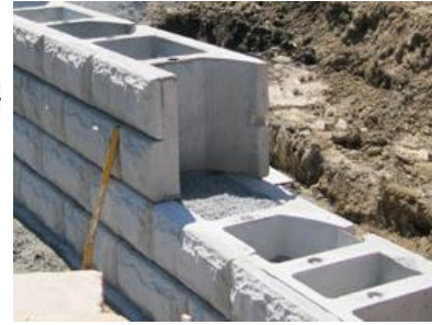
شكل (١٥): نماذج مختلفة لاستخدام بلوكات الطوب المتداخلة والمفرغة في الحوائط الحاملة، شبكة الإنترنت.
