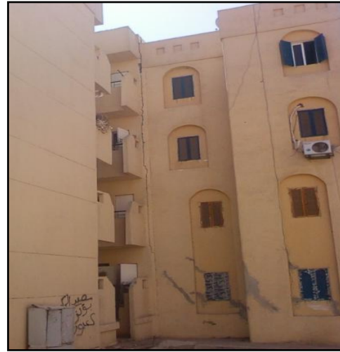
شكل (٤-٣٦): نماذج العمارات التى تعاني تشققات كبيرة بمنطقة زينهم.
