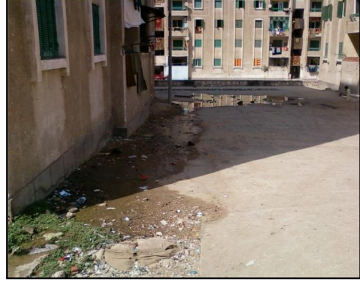
شكل (٤-٨٠): طفح ناتج من شبكات البنية التحتية بشوارع منطقة الدويقة
