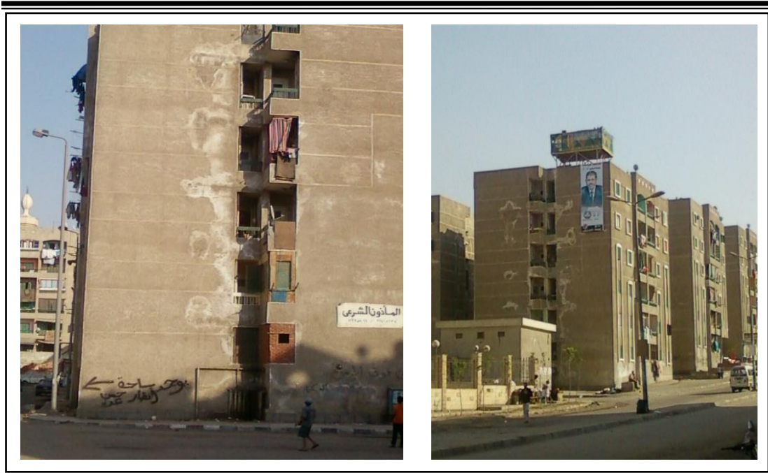
شكل (٤-٧٠): نماذج من الوحدات السكنية التي تعاني من تسريب شبكات المياه والصرف.
