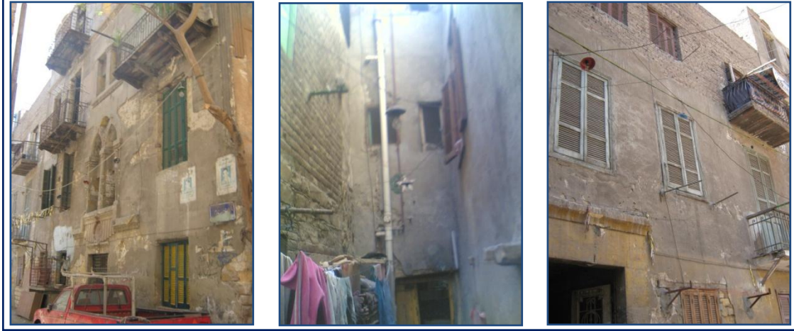
شكل (٣-٨): شكل المباني بعزبة هريدى قبل التطوير (١) .
