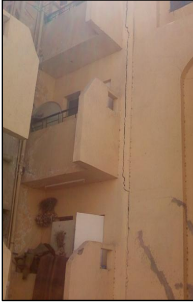
شكل (٤-٢٤): نماذج العمارات التي تعاني من تشققات بالمرحلة الثالثة بمنطقة زينهم.
