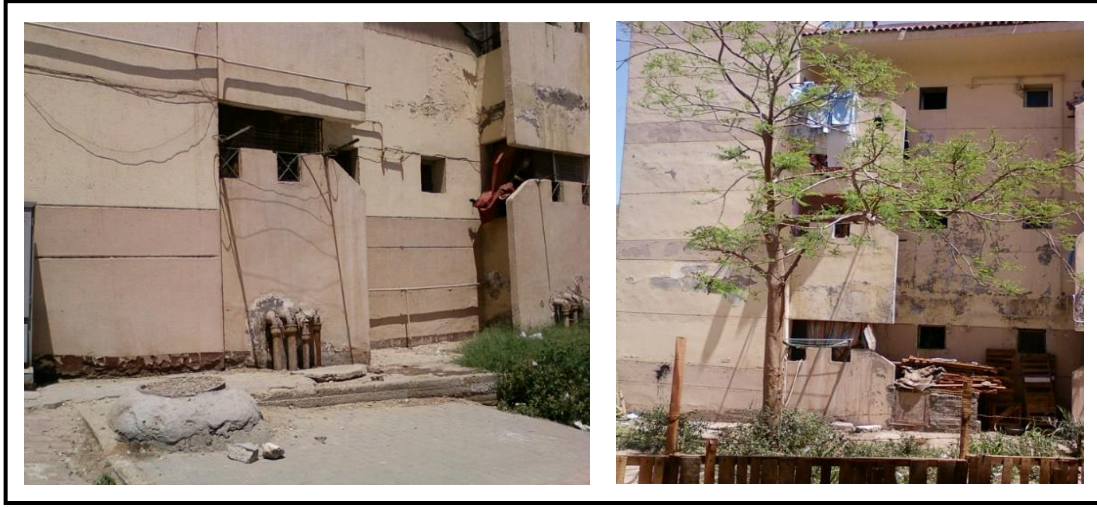
شكل (٤-٣٥): نماذج العمارات التى تعاني من تسريب المياه بمنطقة زينهم.
