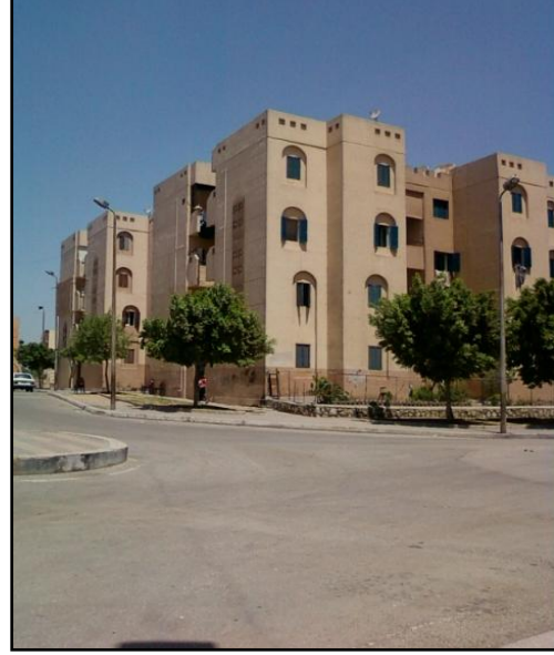
شكل (٤-٢٩): حالة الطرق الرئيسية بمنطقة زينهم.
