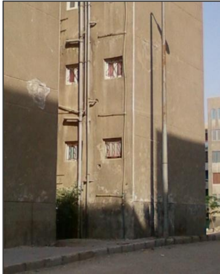
شكل (٤-٥٧): نموذج للوحدات السكنية التي تعاني من تسريب شبكات المياه والصرف.
