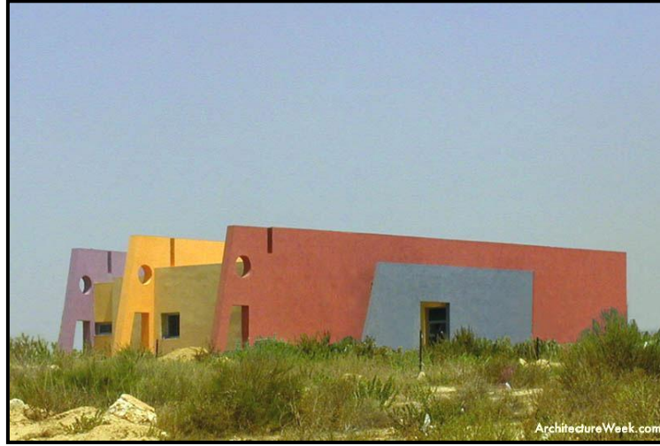
صورة رقم ( ٤-١٧ ) يوضح الواجهة الجانبية للروضة
