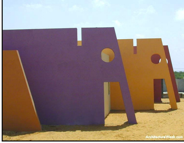
صورة رقم ( ٤-١٦ ) يوضح الواجهة الجانبية للروضة (٢٧٥)
