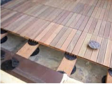
شكل (٢-١١): تفصيلية توضح استخدام بلاطات خشب التيك في عمل الارضيات
