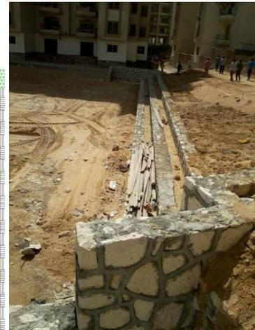
شكل (٤-٥): التغطية بالخرسانة لحماية الميول
