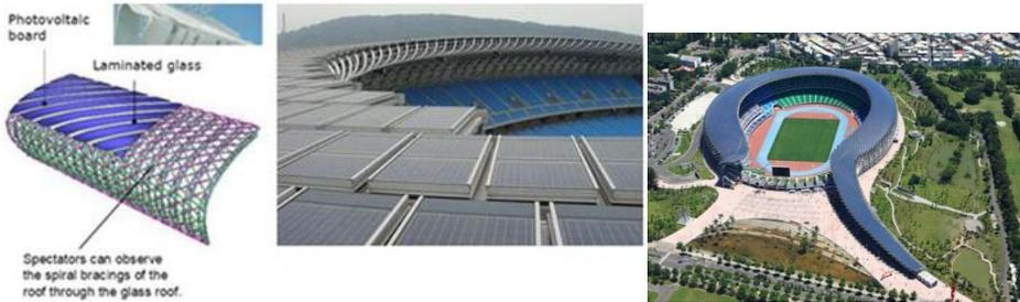
شكل (١- ١):صورة لاستاد عالم الألعاب تغطية السقف كاملا بالخلايا الكهروضوئية
