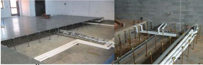
صورة (٤٣) توضح نظام أرضية توزيع الهواء في الفراغات<sup>٢٩٠</sup>
