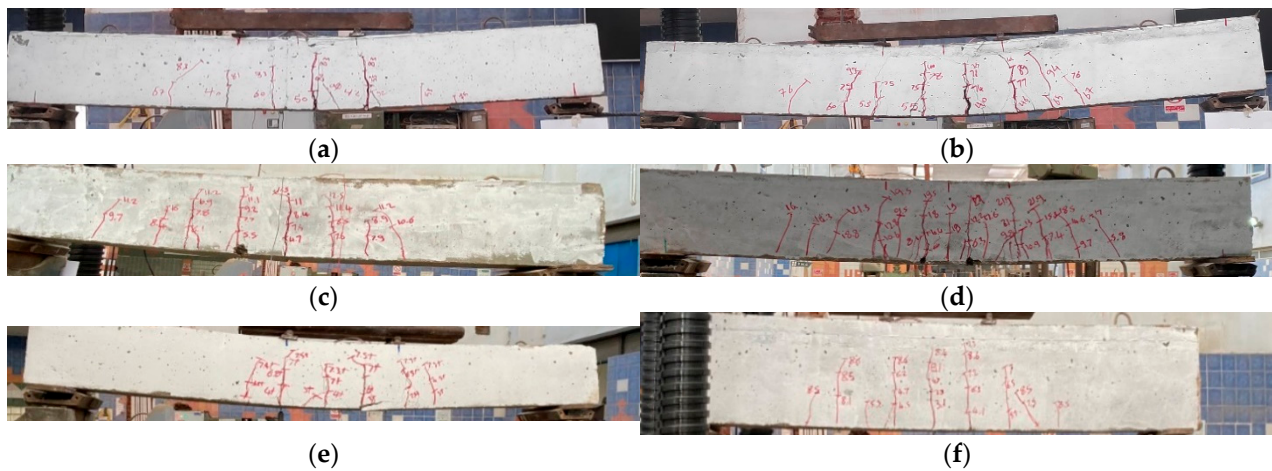
Figure 7. Cracks distribution patterns for all tested beams. (a) CC—2 T 10—300, (b) GPC—2 T 10—300, (c) GPC—2 T 12—300, (d) GPC—2 T 16—300, (e) GPC—2 T 10—250, (f) GPC—2 T 10—350.
