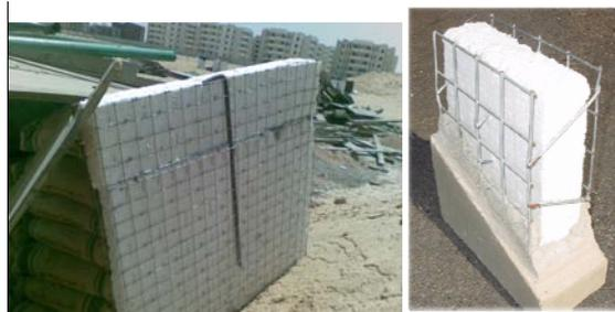
شكل (٦-٦) توضيح للوحدة المكونة من الفوم و الشبكة الحديد
