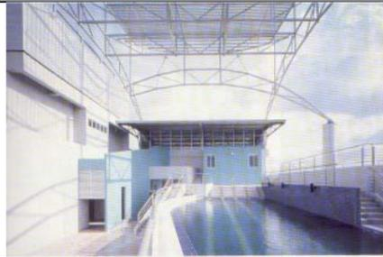
في هذا المبنى نجد ان السقف غير تقليدي فهو يشمل pool الى جانب عمل screen shade ونظام تجمع مياه المطر كما في شكل ( ٣- ٧ )
