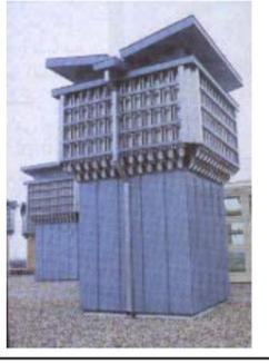
العشرون مدخنة المحيطة بالمسقط يعلوها ما يسمى بكواسر الرياح (Wind baffles) كما في شكل (٣-٢٠) والوظيفة الأساسية لتلك الكواسر منع الرياح ذات السرعات العالية من الدخول من أعلى المدخنة وبالتالي عكس الهواء الفاسد حتى لا يدخل مرة أخرى
