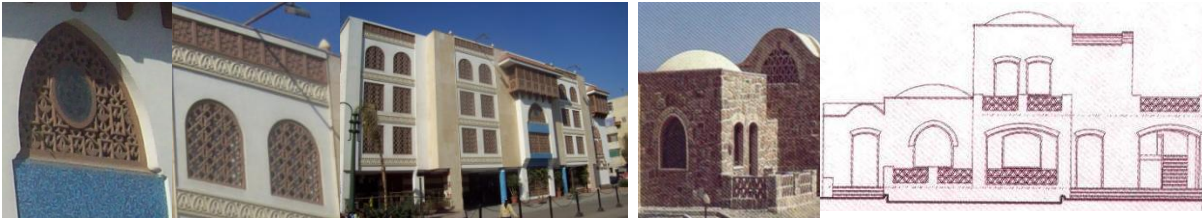
شكل (٤- ١٧) استخدام العقود المدببة والمنخفضة وكذلك العقود المدببة والنصف دائرية بنفس الواجهة (تصوير بواسطة الباحث)
