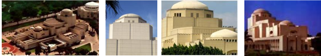
شكل (٤- ٥٨) استعمال القبة فوق بهو المدخل، وقبة أخرى فوق كتلة المسرح الرئيسي (فوق غرفة المعدات والتجهيزات) كشكل جمالي، وكذلك للوصول إلي الطابع المعماري الذي ظهر بالعمارة المصرية بعد دخول الإسلام (تصوير بواسطة الباحث)
