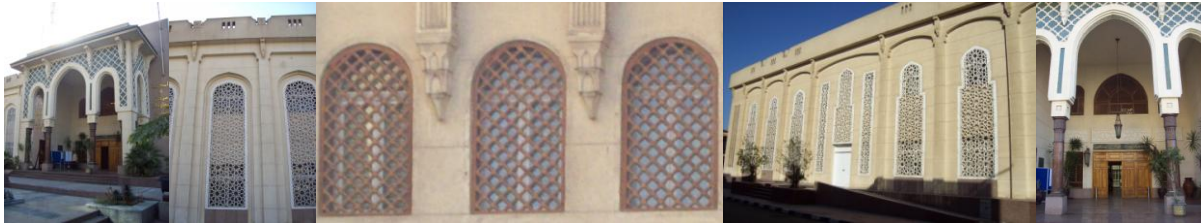
شكل (٤- ١٦) استخدام العقود المدببة والنصف دائرية بالنوافذ الخارجية بغض النظر عن أي معاني (تصوير بواسطة الباحث)
