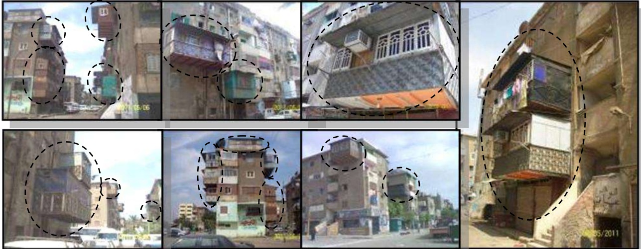
شكل (٤- ٢٦) ظهور بعض الحلول بواسطة السكان وذلك من خلال تزويد بعض الغرف السكنية بأحدي جوانب المبني بوحدات صندوقية تتكون من كابولي من الحديد وحوائط من الخشب والالومنيوم وسقف من الصاج المعرج (تصوير بواسطة الباحث، ٢٠١١)
