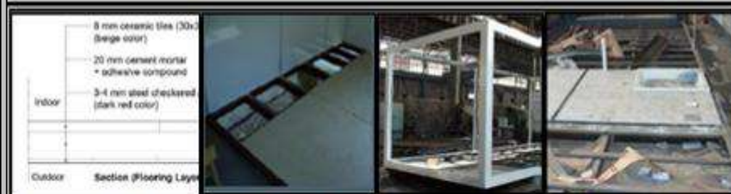
المراحل المختلفة لتثبيت الطبقات على صفائح فولاذية ذو عوارض الأرضية بالمناطق الرطبة
