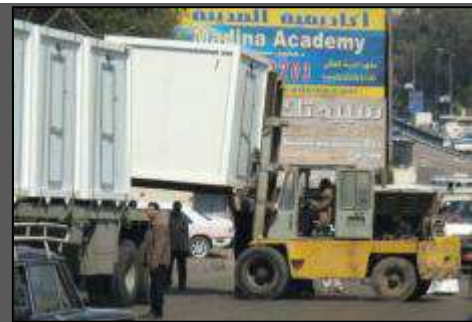
الرافعة تحمل المنشأ (الكرفان) ذات الحجم الصغير إلي المقطورة
