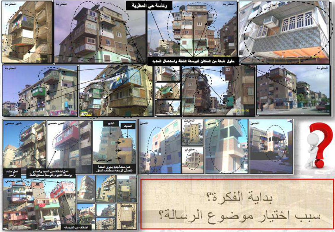
شكل (١- ١) اللجوء إلى الإضافات بالإسكان الحكومي بشوارع الكابلات بالمطرية (بواسطة الباحث، ٢٠٠٩م)
