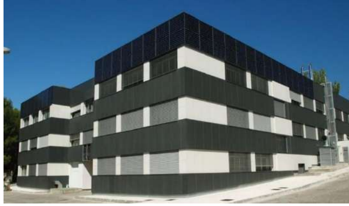
شكل (٩٦-٣) المبنى بعد التجديد وإعادة تجديد مبنى مكاتب "سيمات" بمدريد إسبانيا المصدر: IEA PVPS Task 15, Report
