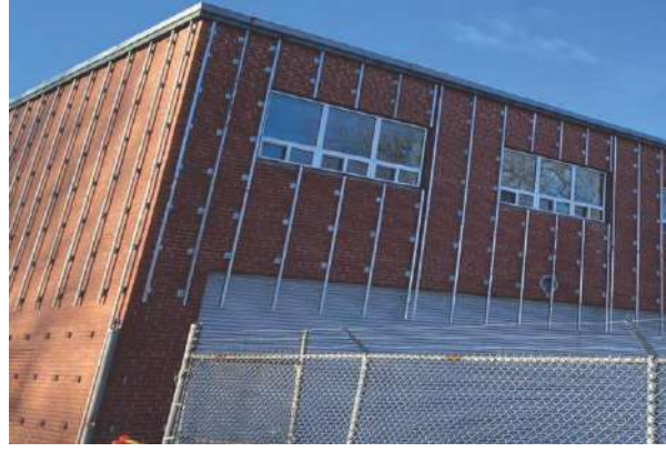
شكل (٦٧-٣) طريقة تثبيت المرحلة الأولى الدعائم الرأسية على جدار الواجهة
