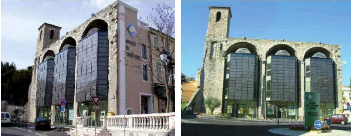
شكل (٣-٤١) مبنى مكتب السياحة من بقايا مبنى الكنيسة التاريخي في مدينة "أليس" بفرنسا
