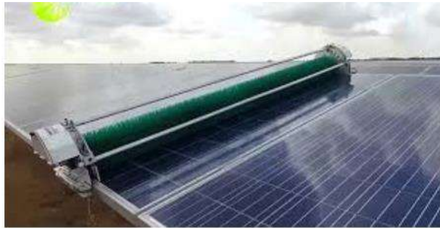
شكل (٧٨-٣) نظافة الخلية الكهروضوئية بشكل نصف آلي المصدر: https://solarabic.com/learn/2019/04/solar-pv-panels-cleaning
