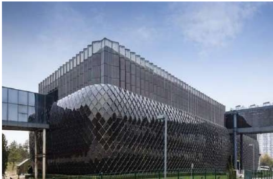
شكل (٣-٥٧) مبنى شركة "هانرجي"، ٢٠١٤ بكين، الصين، تركيب ألواح BIPV بطريقة منحنية على الواجهة المصدر: https://www.energytrend.com/news/20141030-7665.html
