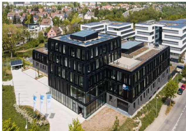
شكل (٥٤-٣) مبنى مركز الأبحاث للطاقة الشمسية والهيدروجين بألمانيا، تركيب ألواح BIPV في الجدران التقليدية
