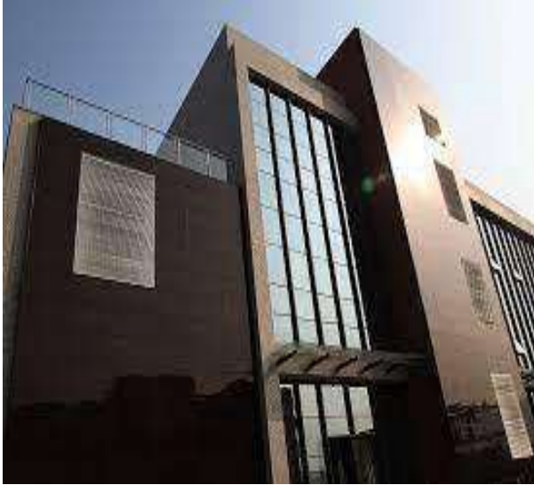
شكل (٥٢-٣) مبنى Hanergy Office، جوانجدونج، الصين، تركيب ألواح BIPV في الجدران التقليدية
