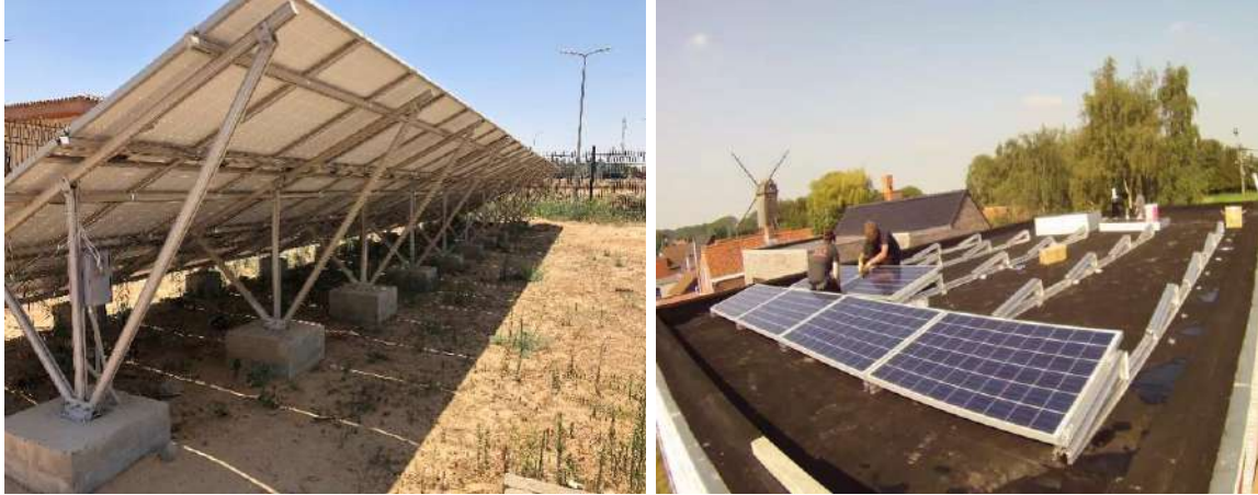
شكل (٣-٢٢) طريقة تثبيت نظام BAPV
