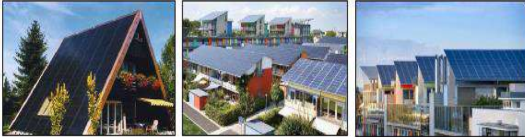
شكل (٣-٤٩) تركيب ألواح BIPV بشكل مائل على الأسطح
