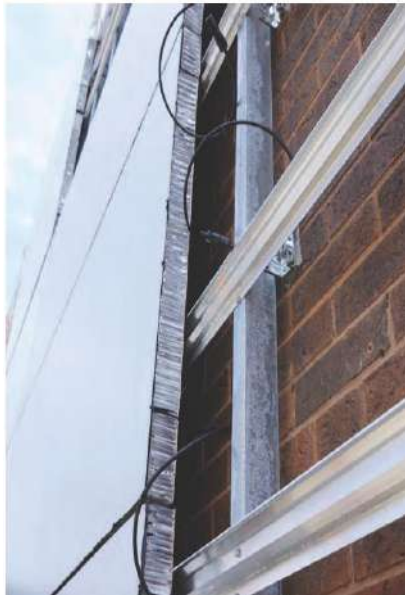
شكل (٦٩-٣) طريقة تثبيت المرحلة الثالثة الألواح الكهروضوئية على العوارض الأفقية بجدار الواجهة
