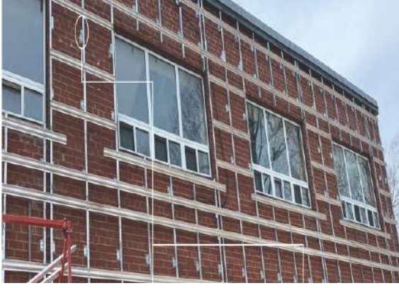
شكل (٦٨-٣) طريقة تثبيت المرحلة الثانية العوارض الأفقية على جدار الواجهة
