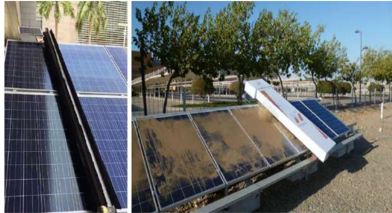
شكل (٣-٨١) نظافة الخلية الكهروضوئية باستخدام تقنية نوماد من خلال ضغط الهواء المصدر:
