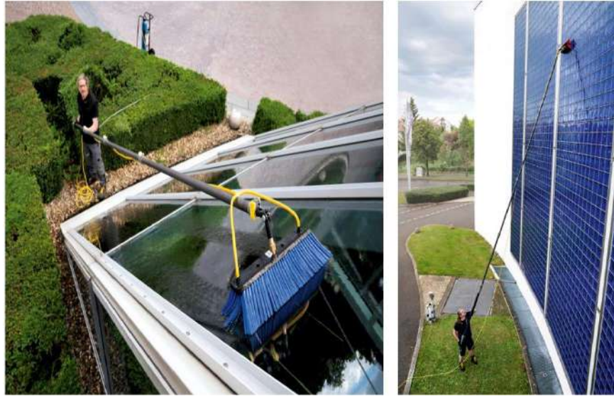
شكل (٧٧-٣) نظافة الخلية الكهروضوئية باستخدام أجهزة يدوياً لتنظيف الواجهات المصدر: https://www.kaercher.com/in-t/inside-kaercher/company/media-information/media-information/2169-new-accessories-for-cleaning-facades-and-solar-power-installations.html
