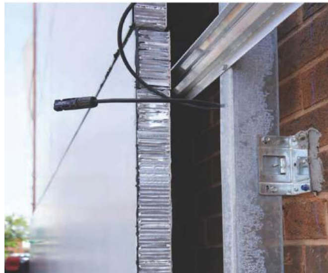
شكل (٧٠-٣) تفاصيل تثبيت نظام BIPV على جدار الواجهة
