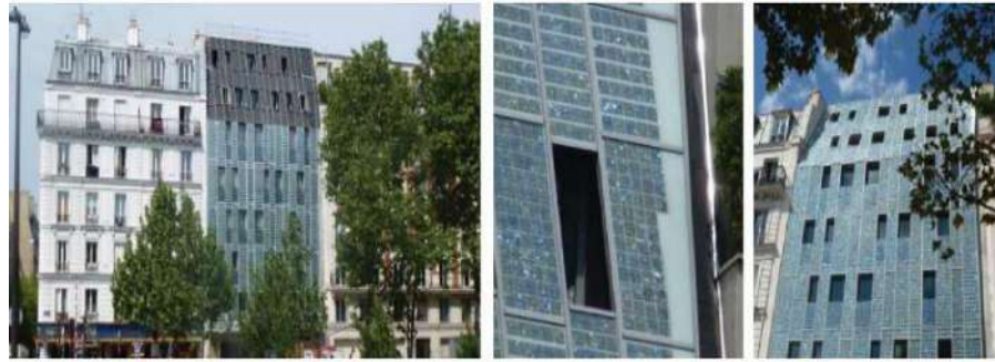
شكل (٥٢-٣) مبنى Hanergy Office، جوانجدونج، الصين، تركيب ألواح BIPV في الجدران التقليدية
