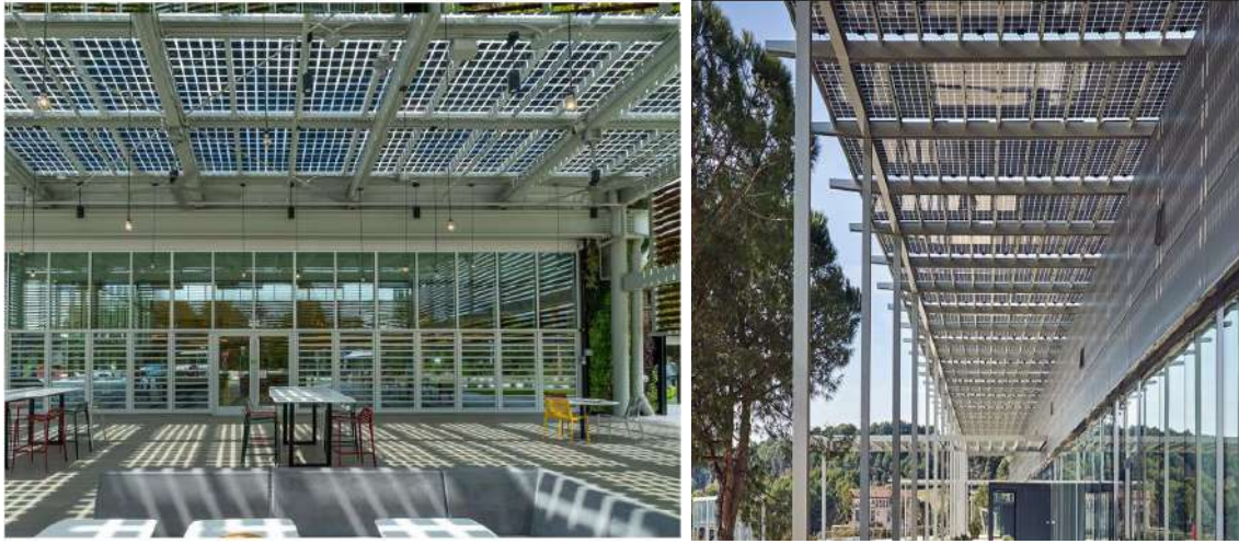
شكل (٦٠-٣) تركيب ألواح BIPV في المظلات الخارجية
