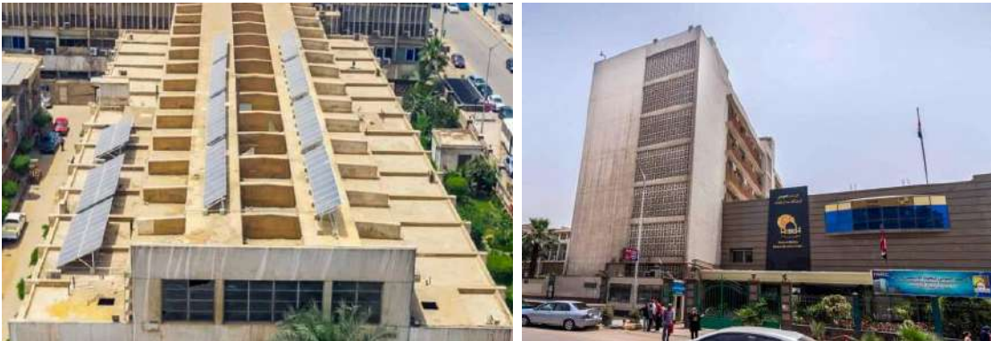
شكل (٢٧-٣) المركز القومي لبحوث الإسكان والبناء بالدقي، الجيزة
