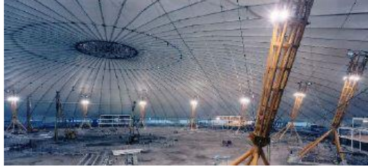
منظور داخلي يوضح العناصر الإنشائية وعلاقتها بالسقف شكل (31-3) قبة الذكري الألفية.
