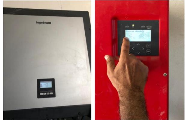
شكل (8) المحول Inverter الذي يقوم بتحويل التيار المستمر لتيار متردد
