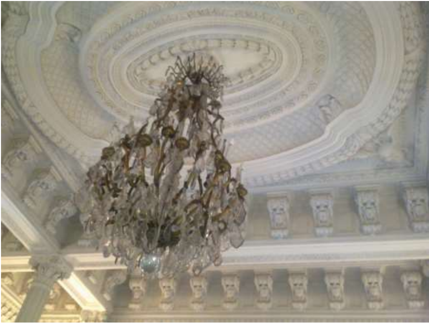
لوحة ( ٢١٠ ) سقف الطابق الأرضى قصر العروبة
