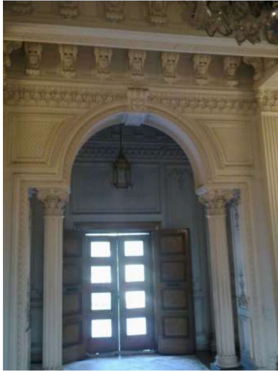
لوحة (٢٠٨) دهليز المدخل بالطابق الأرضي قصر العروبة
