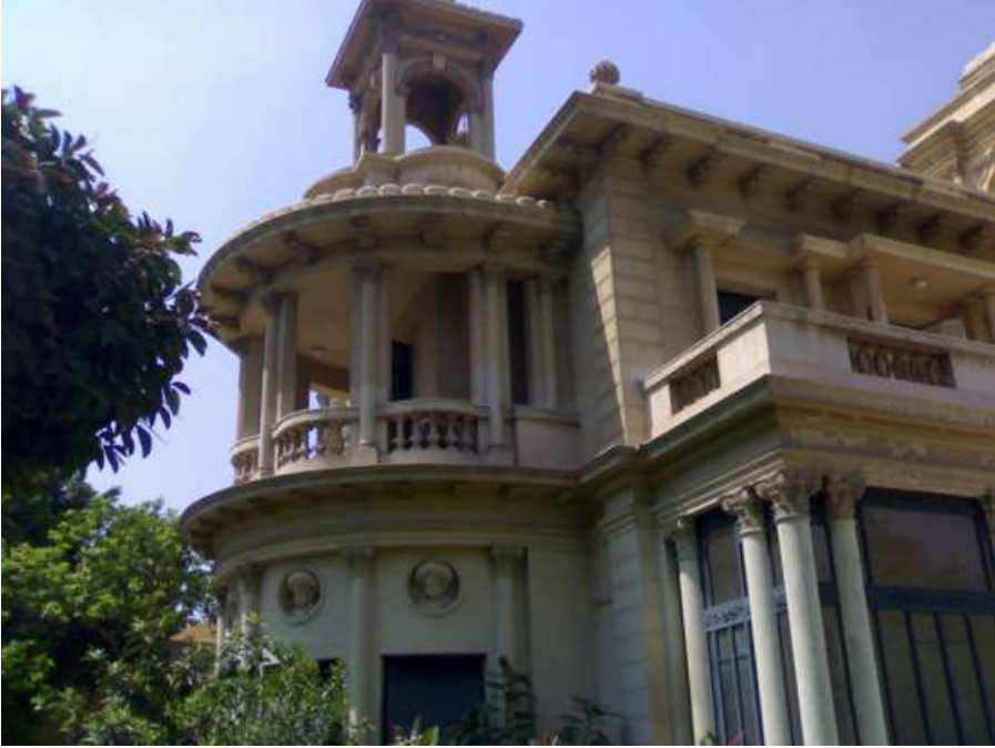
لوحة (٢٠٥) الواجهة الجانبية لقصر العروبة
