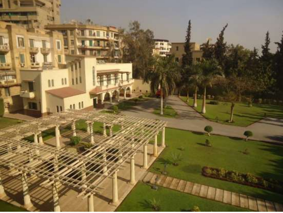
لوحة ( ٢٣٠ ) المبني الملحق قصر الأندلس
