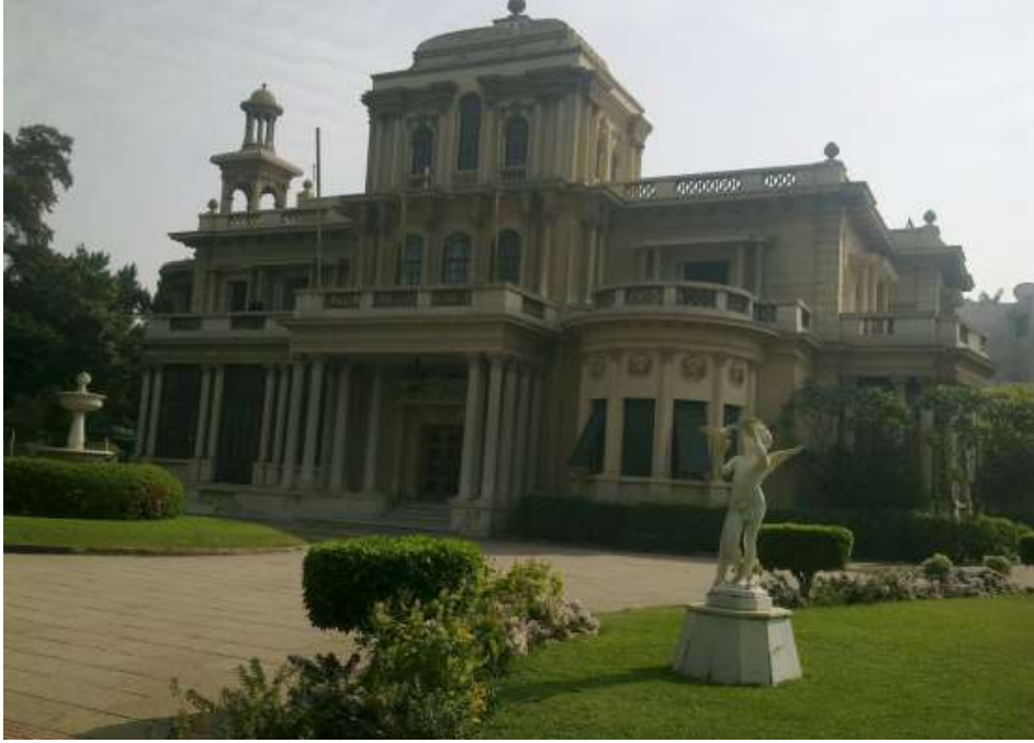
لوحة (٢٠٣) الواجهة الرئيسية قصر العروبة
