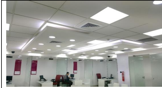
شكل (5.9): استخدام ألواح الجبس في الأسقف والبلاطات 60*60 سم (فرع الرمال).
