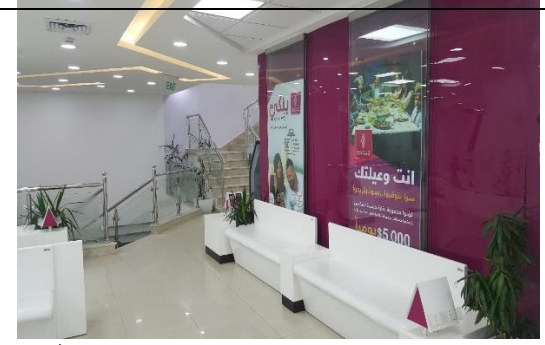
شكل (5.18): استخدام البلاستيك الاكريليك في كسوة الحوائط ( فرع الرمال)
