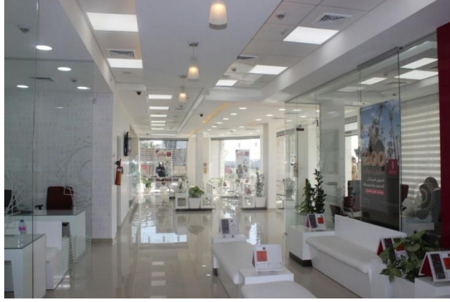
شكل (5.42): استخدام الواح الجبس في الاسقف وبلاطات 60*60سم ، واستخدام بلاط البورسلان 60*60سم.
