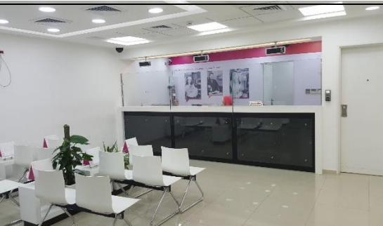
شكل (5.20): استخدام الواح الجبس وبلاطات السقف 60*60سم. ( فرع الرمال)
