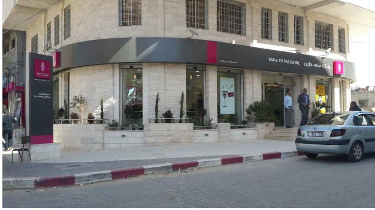
شكل (5.37): استخدام حجر المطبة والملطش، استخدام زجاج السكوريت والواح الكومبوزيت وپلاستيك الاكريليك.
