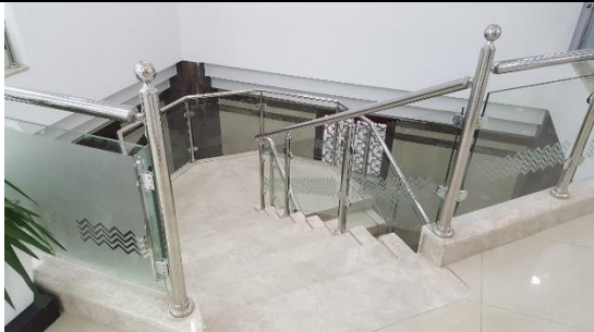
شكل (5.12): استخدام الرخام العماني في كسوة الادرار (فرع الرمال).
