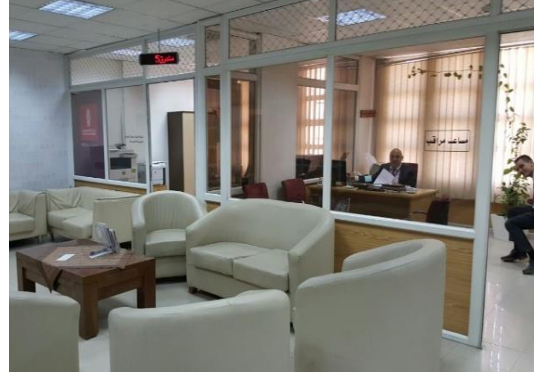
شكل (5.24): استخدام قواطع الألومنيوم كفواصل بين الفراغات
