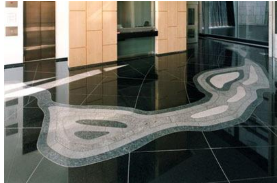
شكل (2.24): أشكال أرضيات الجرانيت باستخدام آلة الووتر جت.
