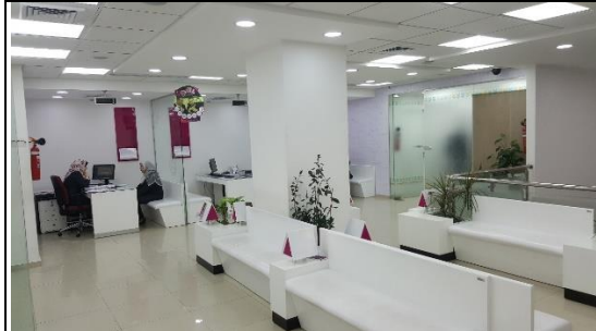
شكل (5.11): استخدام بلاط البورسلان 60*60 سم (فرع الرمال).
