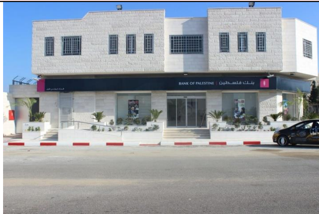
شكل (5.41): استخدام حجر المطبة والملطش، استخدام زجاج السكوريت والنواح الكومبوزيت وبلاستيك الاكريليك
