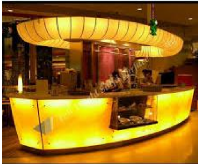
شكل (2.15): توضح تقنية الرخام (أونكس) في عمل الكاونترات وإستخدام الإضاءة من خلاله.
