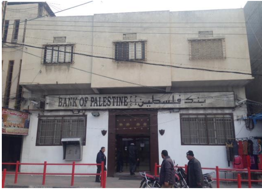
شكل (5.45): استخدام القصارة والدهان ، واستخدام الابواب الحديدية.
