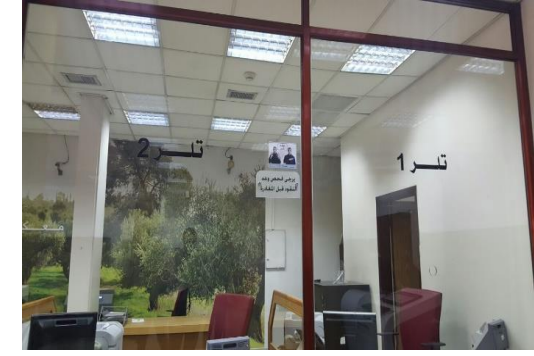
شكل (5.28): استخدام قواطع الألومنيوم كفواصل بين الفراغات
