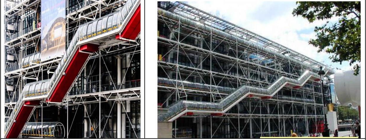
شكل (2-19) مركز بومبيدو الثقافي - فرنسا - باريس - للمعماريين (Piano and Rogers) أستطاع المعماري أن يستغل السلالم المتحركة كعنصر تشكيلي في الواجهات الخارجية للمبنى كعلامة مميزة المصدر: إيمان محمد عيد، الاتجاهات المعمارية المعاصرة، دار الفكر العربي، 2020.
