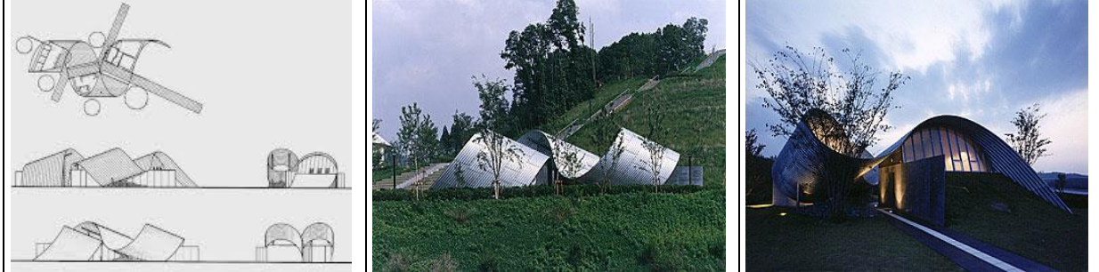
مبنى Springecture H ، تم إنشائه سنة 1998 من ألواح الصلب المموج المستخدمة كقوالب للمبنى للجمع بين الداخل والخارج للمبنى ، والتي تم إنشاؤها باستخدام شكل حلزوني مستقل
