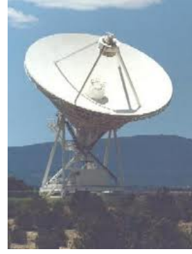
شكل (٧-١) هوائيات تحديد المواقع بتقنية VLBI
