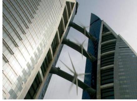
شكل (٣-٢) يوضح استغلال قوة الدفع الصادرة من توربينات الهواء في تحويلها إلى طاقة كهربائية لتشغيل المبنى
