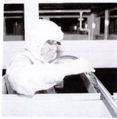
شكل (٣-٦٣). حقن فواصل السقف بالجل المائي ( السيليكون). المصدر: ( www.cleanpac.com )
