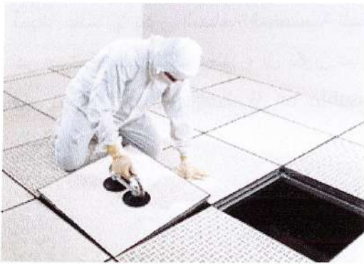
شكل (٣-٥٩). وحدات الأرض المرتفعة ويظهر فيها الوحدات المصممة من الأخرى المفرغة الخاصة بسحب الهواء. المصدر: ( www.cleanpac.com )
