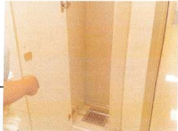
دواليب حفظ المتعلقات الشخصية مزودة بمصدر للتهوية أعلاها وفتحات لسحب الهواء من الأسفل
