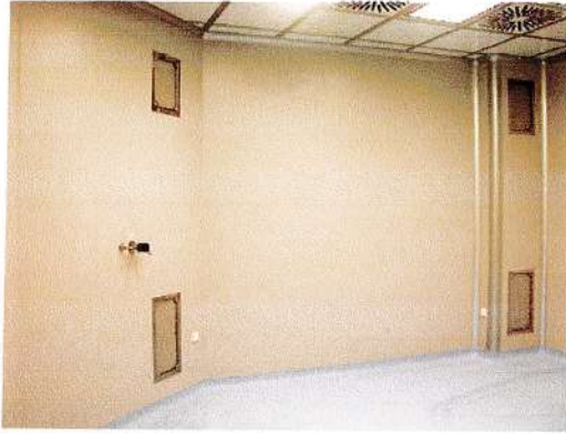
شكل (٣-٢٧) . صورة داخلية لاحدى الغرف النظيفة بمحيطها المصمت وفتحاتها المستوية وأركانها المستديرة.
