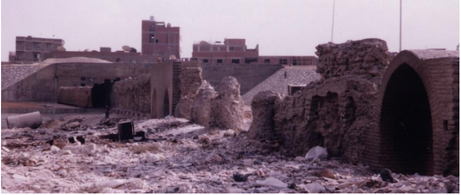
بقايا العقود المتتالية لقناطر مياه "ابن طولون". شكل رقم (29)
