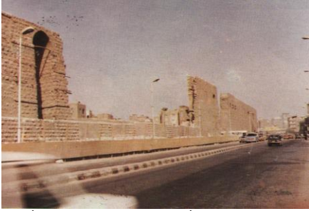
الأجزاء التي سقطت من قناطر "مجرى العيون" في الجزء الواقع أمام مقابر المسيحيين وأعيد بنائها عام 1984م، بقسم الدراسة (ب)(1). شكل رقم (95)
