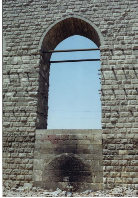
أحد عقود مجراه مياه القناطر والتي لها جلسة للتقوية. شكل رقم (49)
