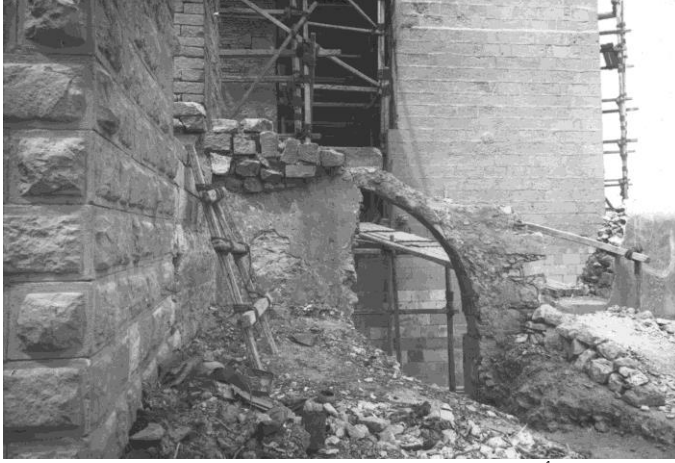
أحد العقود التي تحمل المنحدر الصاعد(1). شكل رقم (37)
