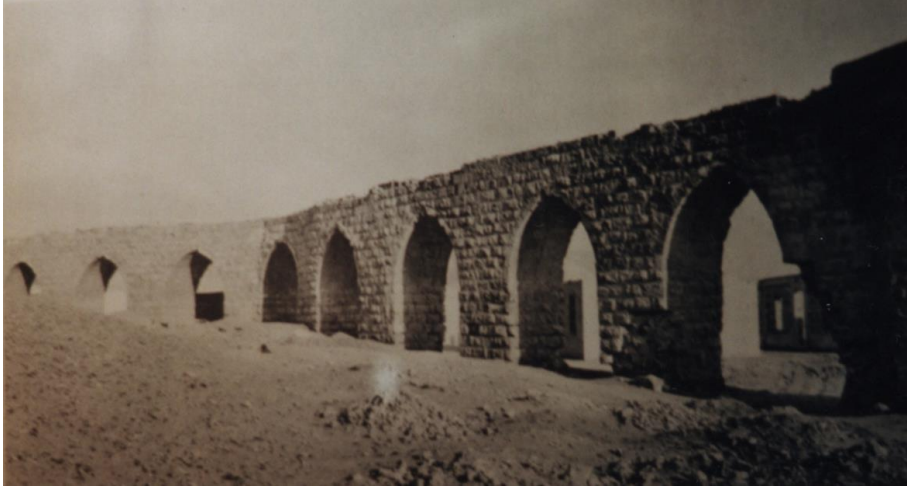
جزء من قناطر "مجرى العيون" بقسم الدراسة ( د ) وقد أحاطت بها المقابر، عن "كريزول" عام 1940م (1) . شكل رقم (89)
