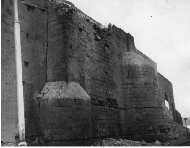
بعض الدعامات الشبه دائرية الساندة لقناطر مياه "مجرى العيون". شكل رقم (51)
