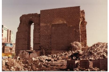
الأجزاء التي سقطت من قناطر "مجرى العيون" في الجزء الواقع أمام مقابر المسيحيين وأعيد بنائها عام 1984م، بقسم الدراسة (ب)(1). شكل رقم (95)
