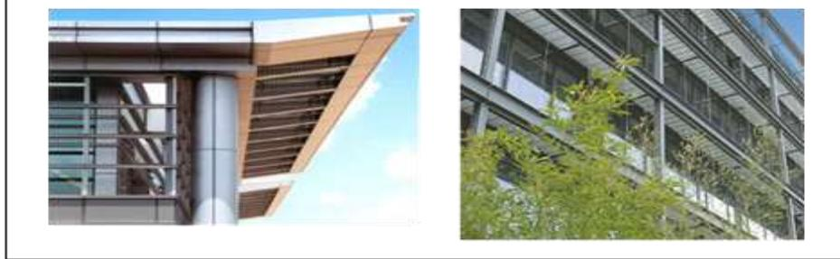
شكل (٢- ٢٥) امثلة لحواجب التظليل الكهروضوئية الثابتة- المصدر: www.smart elevation.com
