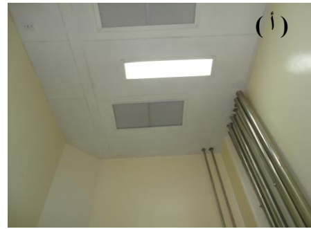
شكل(١-٢٠). حالتين دخول امدادات المواد والغازات من السقف المعلق. (أ) بجوار الحائط-(ب) منتصف الفراغ. المصدر: الحالات الدراسية التي تم تحليلها في الدراسة الميدانية.
