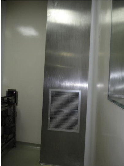
شكل (١-١٩). حالات مختلفة لمعالجة أماكن سحب الهواء من الأسفل بفراغ الإنتاج . المصدر: الحالات الدراسية التي تم تحليلها في الدراسة الميدانية.
