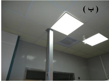
شكل(١-٢٠). حالتين دخول امدادات المواد والغازات من السقف المعلق. (أ) بجوار الحائط-(ب) منتصف الفراغ. المصدر: الحالات الدراسية التي تم تحليلها في الدراسة الميدانية.
