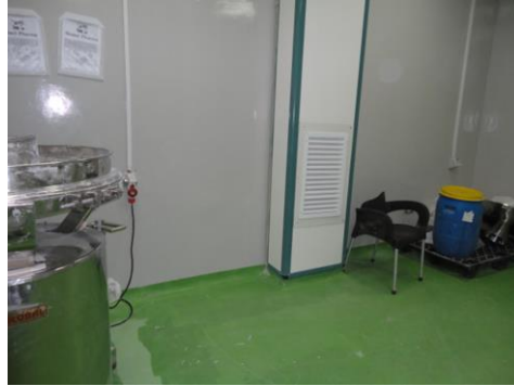
شكل (١-١٩). حالات مختلفة لمعالجة أماكن سحب الهواء من الأسفل بفراغ الإنتاج . المصدر: الحالات الدراسية التي تم تحليلها في الدراسة الميدانية.
