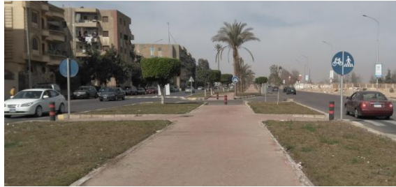
شكل 14: صورة توضح مسار الدراجات والمشاة وتقاطعهم مع حركة عبور المشاة للطريق مع عدم وجود إشارات مرورية تنظم ذلك التقاطع. (من تصوير الباحث)
