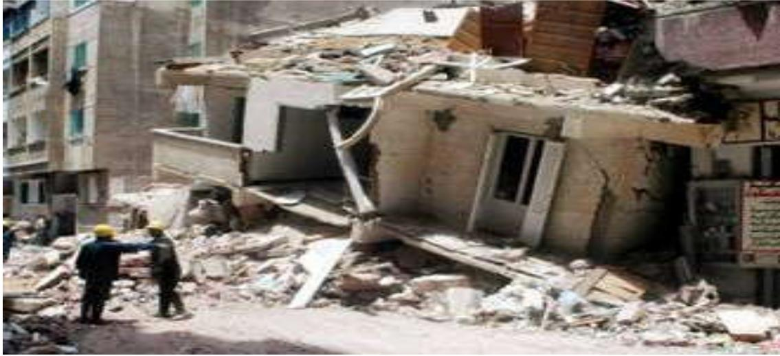
صورة ٣-٢-٦ انهيار العقار رقم ١٣ حارة الجمالية بالسيدة زينب المكون من ٤ طوابق ، مما أدى إلى مصرع ٣ أشخاص وانقاذ ٢٥ أثناء قيام صاحب العقار بترميمه أى أن إتخاذ قرار خاطئ للصيانة ، وعدم الدراية بها أو التدريب عليها او اهمالها أدى إلى انهيار المبنى الذى انتهى عمره الافتراضى أيضا [١٠٢] .
