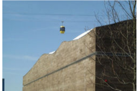
شكل(25_6): منظر خارجي يظهر نهايات كتلة الجناح المتموجة.
