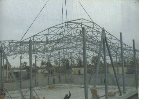
شكل(26_6): منظر خارجي للهيكل الإنشائي المتموج.
