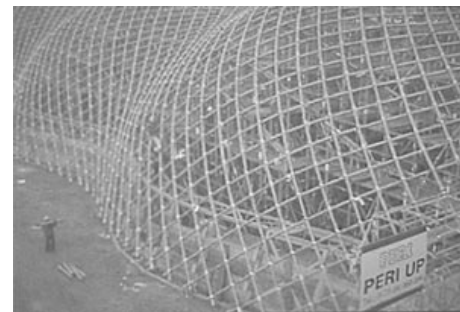
شكل(17_6): منظر يظهر الهيكل الخارجي قبل تغطيته.
