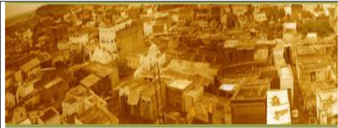
شكل رقم ( ٨-٢ ) منظر عام للسوق القديم والمنازل المحيطة به وغالبية الأسقف خشبية
