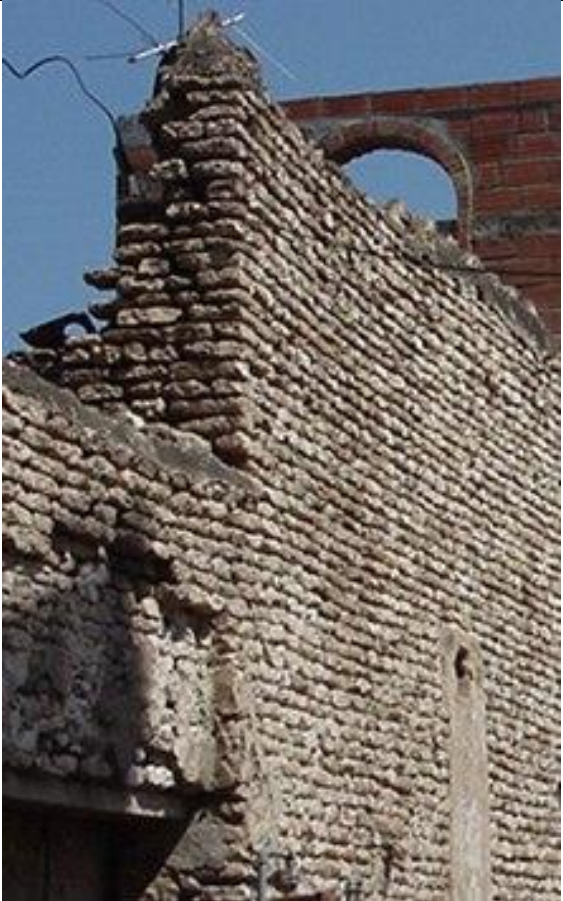
شكل رقم ( ٦-٢ ) يوضح البناء بالجدران الحاملة [١].
