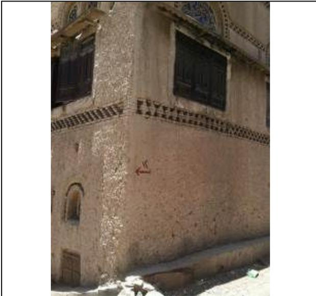
شکل رقم ( ٢-١٤ ) يوضح النوافذ الخشبية التي لاتسمح بالنظر من الخارج للداخل وكذلك القمرينات الملونة التي لها نفس الخاصية في زيادة الخصوصية
