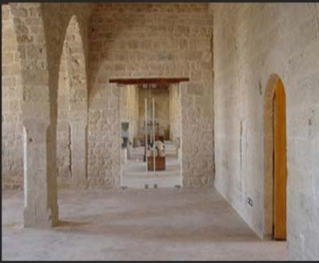
الصورة ( ١٣٣ ) الكافتيريا بعد أعمال الترميم المصدر: مؤسسة الآغاخان الثقافية
