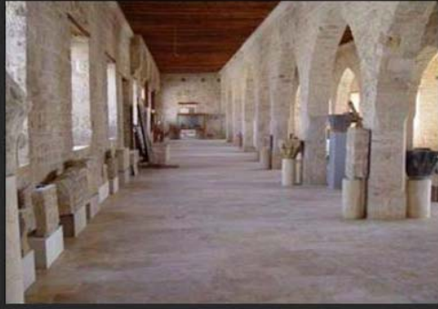
الصورة ( ١٣١ ) : الأعمدة الداخلية للكنيسة بعد الترميم المصدر: مؤسسة الآغاخان الثقافية
