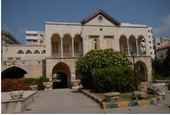
الصورة (٨٠): الواجهة الأمامية لخان الدخان
