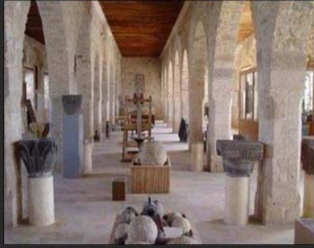
الصورة ( ١٢٩ ) : الأعمدة الداخلية للكنيسة بعد الترميم المصدر: مؤسسة الآغاخان الثقافية
