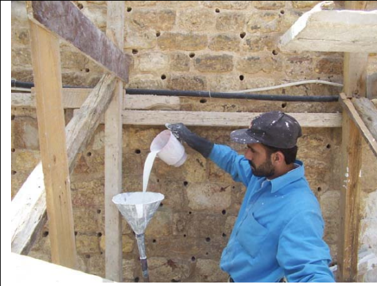
الصورة ( ١٣٤ ): حقن الجدران الخارجية للثكنة المصدر: مؤسسة الآغاخان الثقافية
