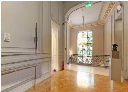
شكل ( 21/3 ) يوضح استحداث نظام للإنذار وللسلامة والصحة المهنية ومقاومة الحريق بمبنى محمود خليل مختار وحرمة ، بعد إعادة تأهيله.
