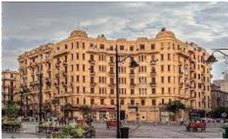
مبنى رقم (4/1) /يوضح أحد المباني بوسط البلد كنموذج لمباني القاهرة الخديوية المصدر: https://encrypted Accessed Date 2021
