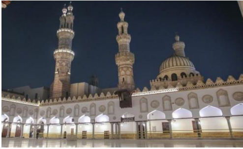
مبنى رقم (14/1) يوضح جامع الأزهر بالقاهرة المصدر : https://www.azhar.eg , Accessed Date 2022
