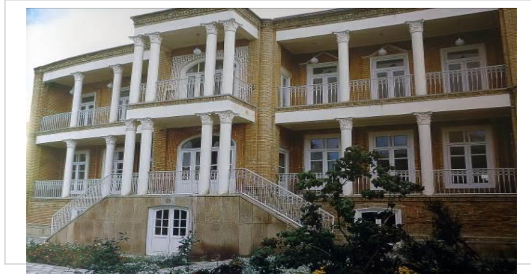
شكل ( 1/3 ) يوضح الجزء الشرقي من المبنى - بُني في فترة القاجار (1)
