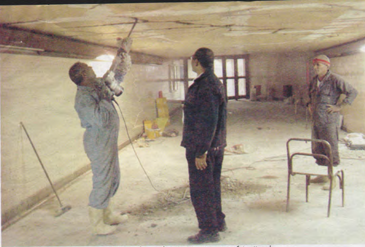
فرق الصيانة تحركت لعلاج التشققات في محطة مترو السادات
